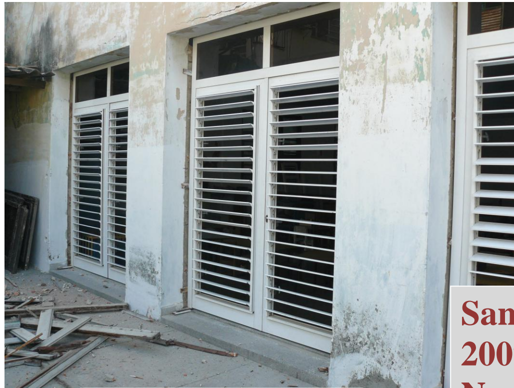
während der Montage
